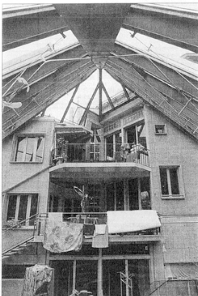
Energetische Architektur im Ökotoxia Felsenau. Der Wintergarten heizt die Leichtsicherwände auf. (Bild Bucher)
